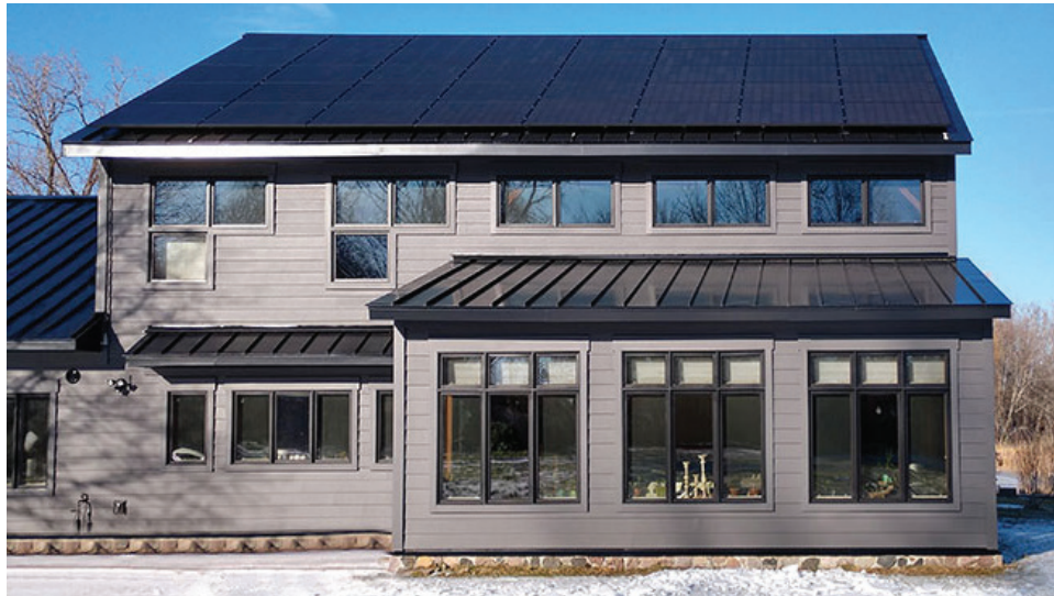
Actual Solaria PowerXT Installation
